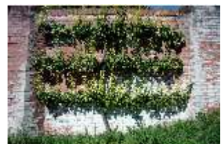
Da.V, Westmauer, DI003702, BSV
