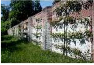
Da.V, Westmauer, DI003698, BSV
