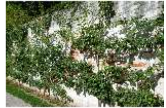
Da.V, Nordwestliche Gartenmauer, DI003731, BSV
