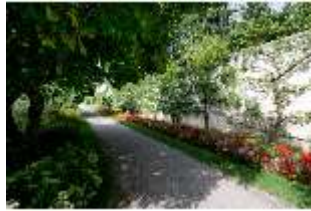
Da.V, Nordwestliche Gartenmauer, DI003728, BSV
