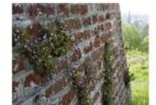
Da.V, Westmauer, DI006829, BSV-
