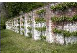
Da.V, Westmauer, DI006828, BSV-
