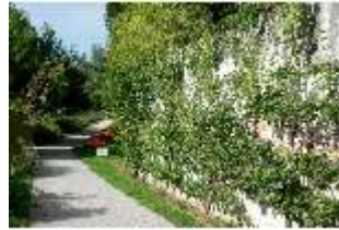
Da.V, Nordwestliche Gartenmauer, DI003730, BSV
