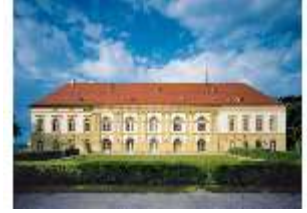
Da.I, Schloss Dachau, Nordostfassade, DE000004, BSV-
